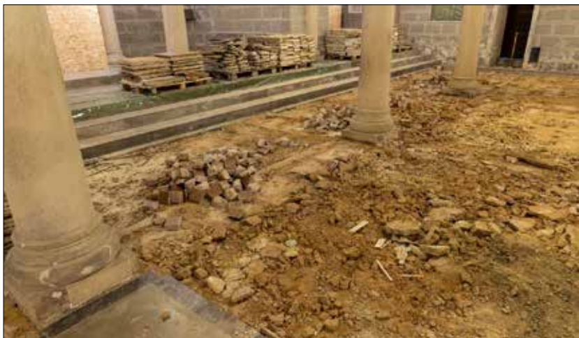
40. ábra. A jelenlegi, agyagba rakott burkolat felszedés közben (fotó: Tóth Zsolt)
