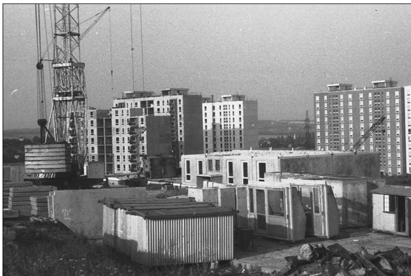
8. kép Félkész állapotú panelépületek a Tildy Zoltán utca északi részén (Forrás: Laufer László fotógyűjteménye, DN)
