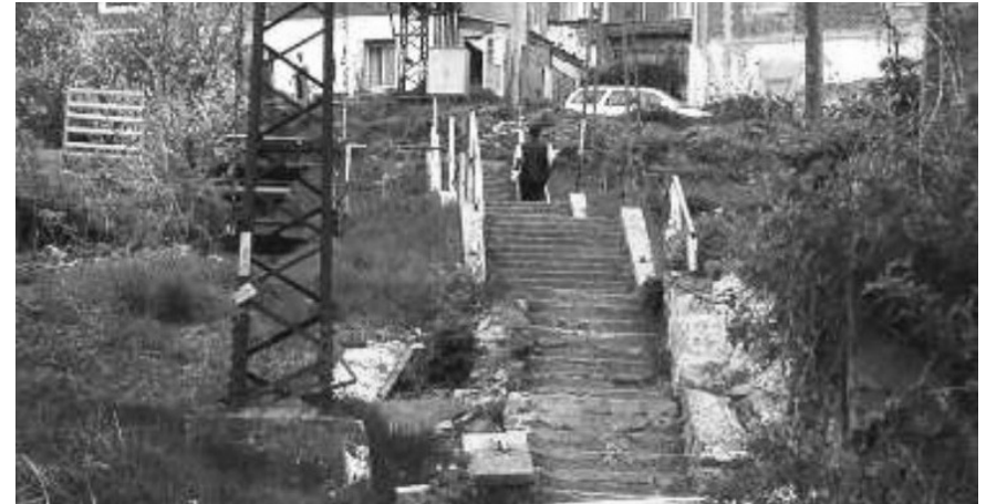
2. ábra: György telep lépcső, a felújítás előtt
